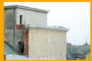
La sortie de secours de l'hôtel...
